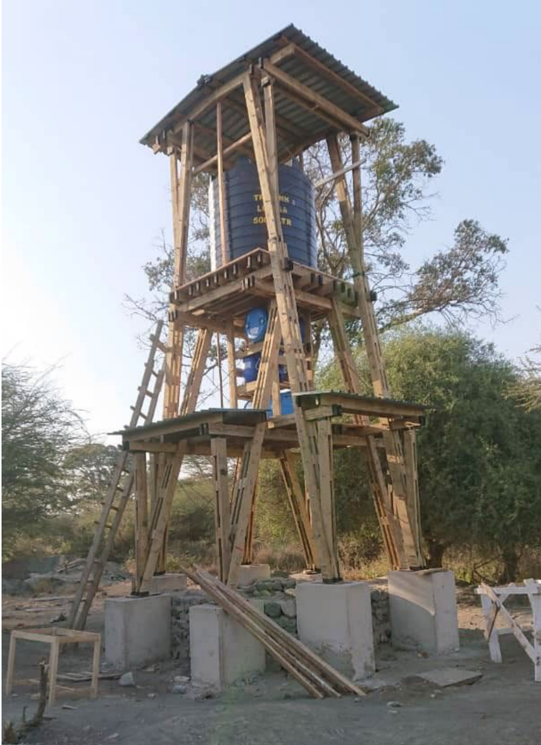
Abb. 15 – Wasserturm kurz vor der Fertigstellung.
