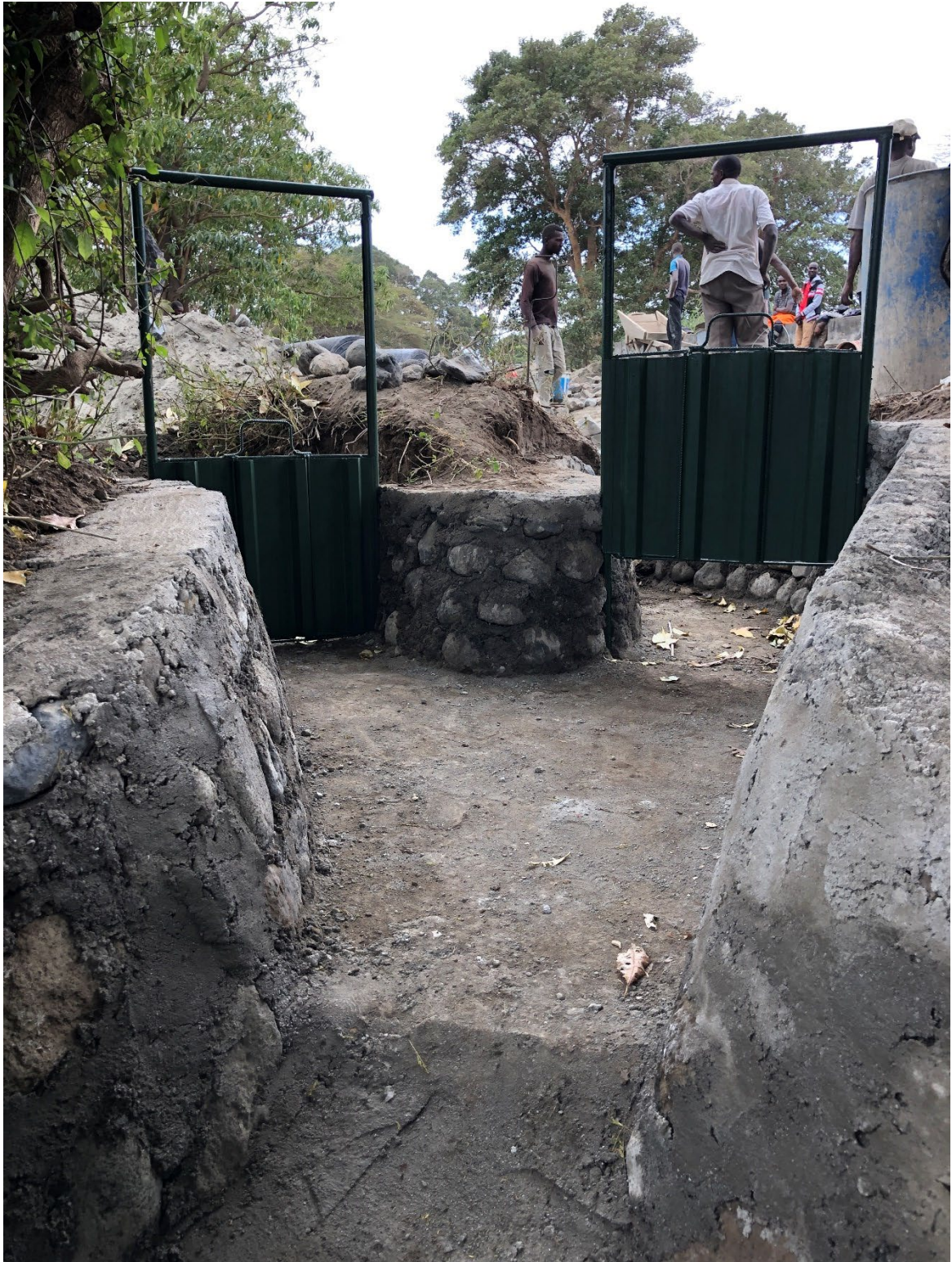
Abb. 10 – Schleusensystem der Wasserfassung.
