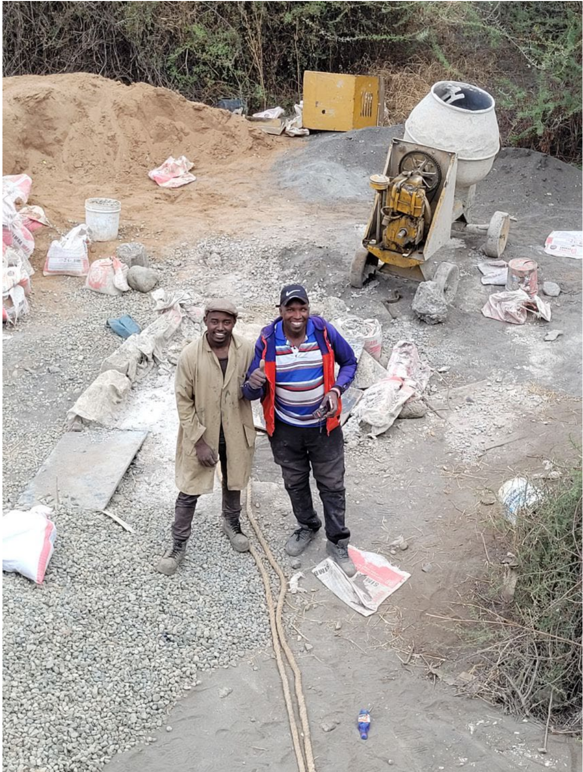
Abb. 13 – Lokale Baustellenikonen. Schweissmeister Mr. Benson (links) und Allrounder und Bauleiter Mr. Papa (rechts).
