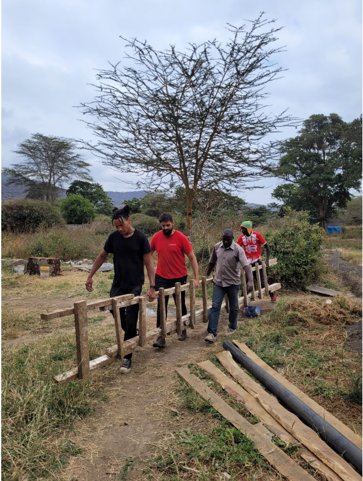
Abb. 6 – Team Wasserversorgung auf dem Weg die Solarpanels zu installieren.
