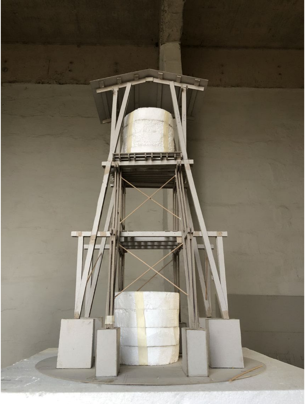
Abb. 14 – Model des Wasserturms mit den zwei 5'000 Liter Tanks.
