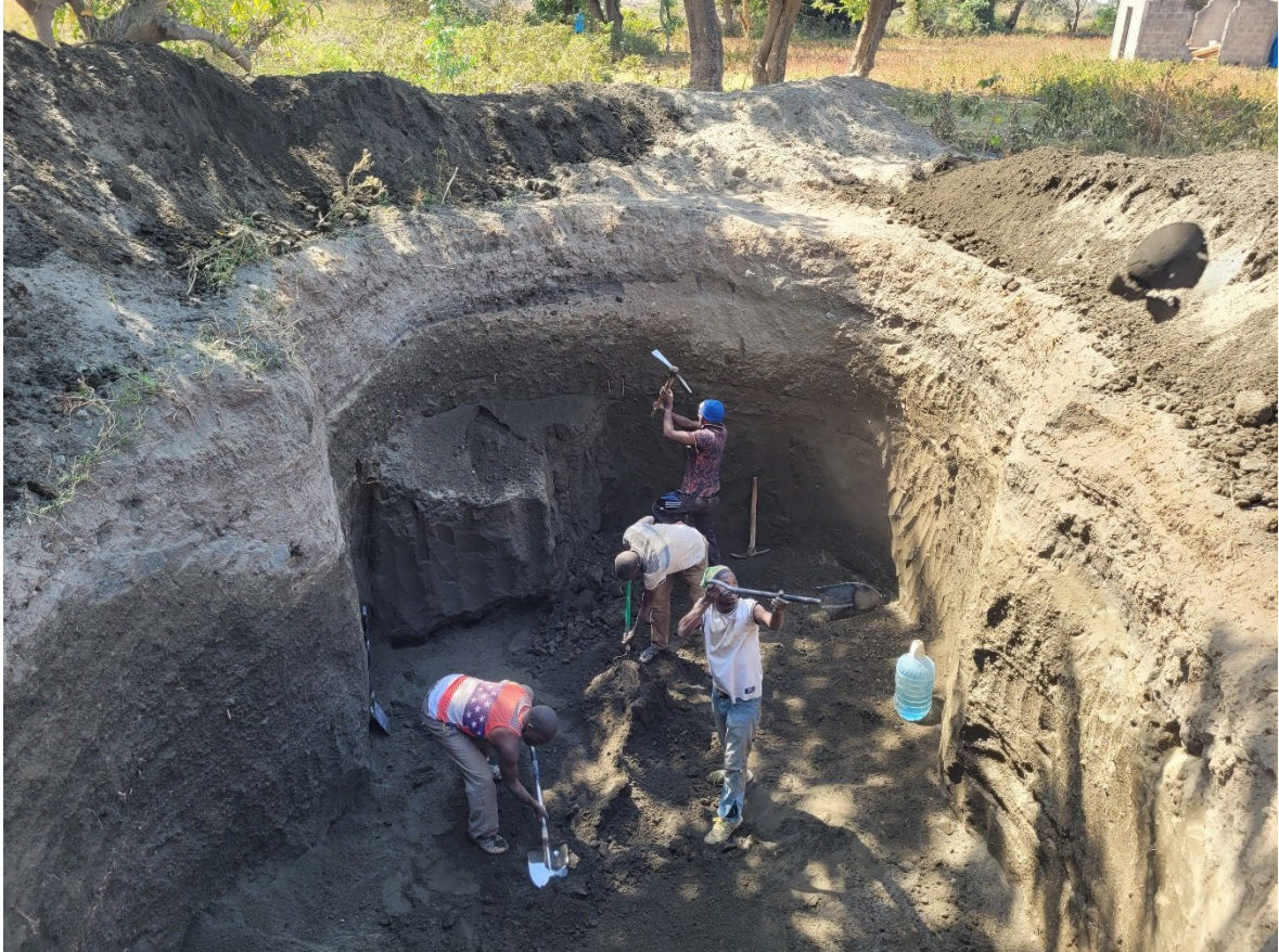
Abb. 5 – Grabarbeiten der lokalen Bauarbeiter für die zwei 10'000 Liter Tanks.
