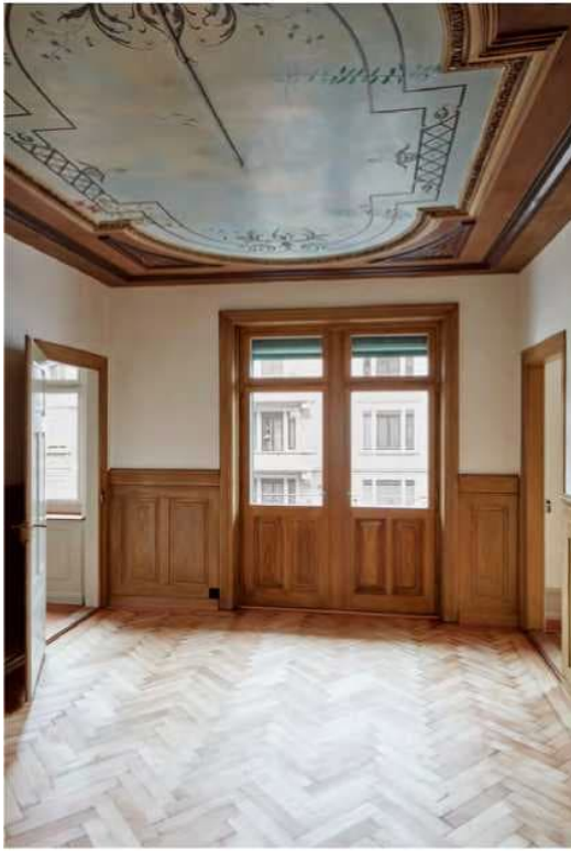
Salon mit bauzeitlichem Parkett
