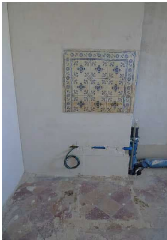
Steigzone Küche: kleiner Durchbruch
