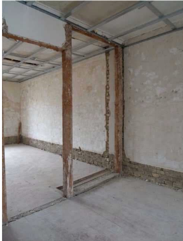
Abbruch bis auf die Tragstruktur.
