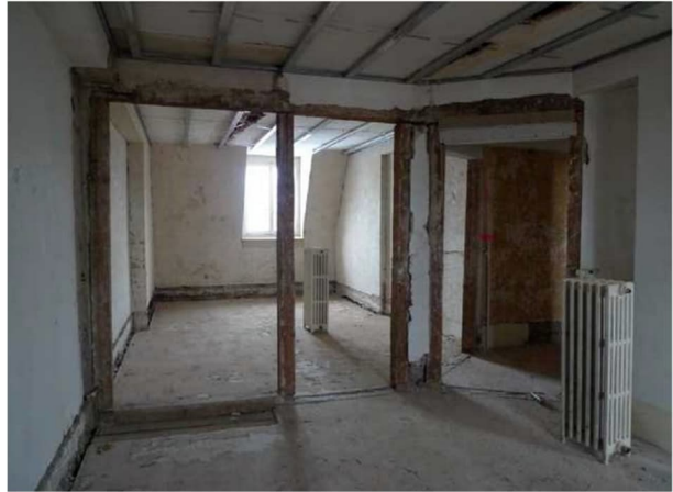
Abbruch sämtlicher Oberflächen
