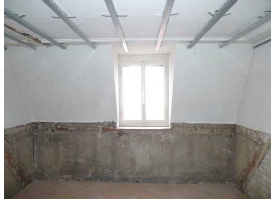
Abhangdecke, Abbruch Brusttäger
