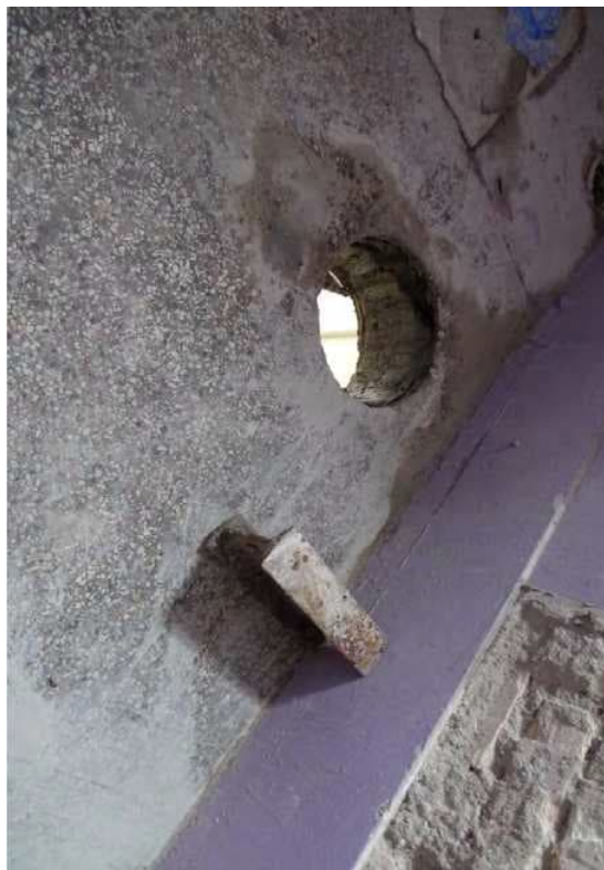
Steigzone Bad: kleiner Durchbruch
