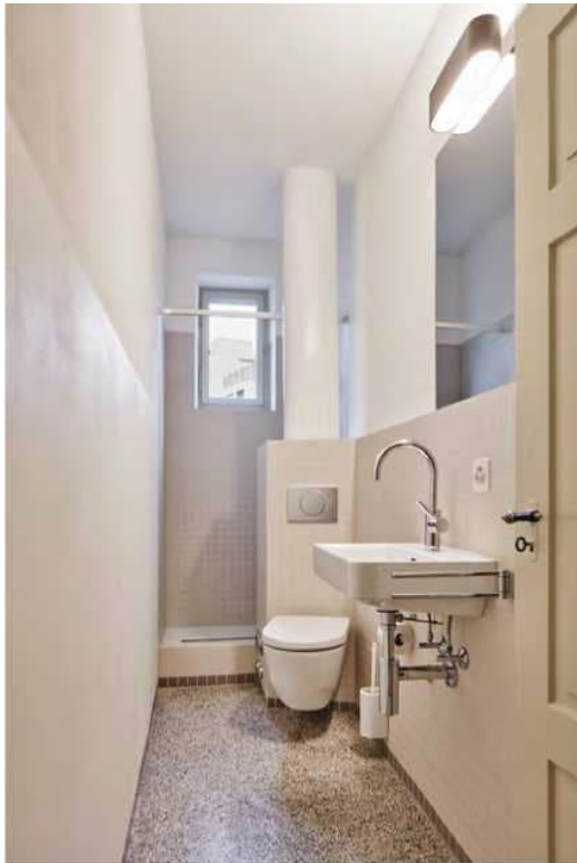
Bad mit bauzeitlichem Terrazzo
