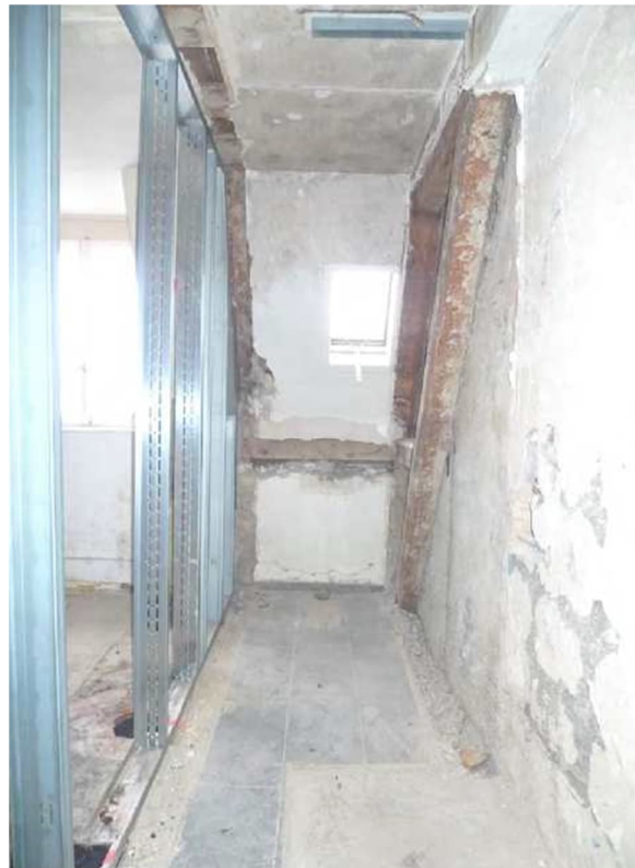
Bad: Wand wird versetzt
