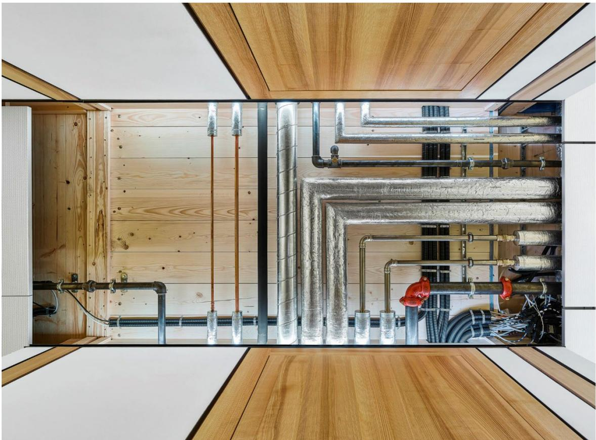
Abbildung 1: Lüftungsanlage der NEST-Unit «Urban Mining & Recycling», Zooey Braun, Stuttgart
