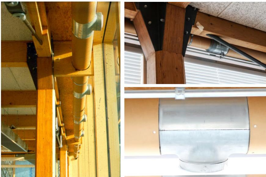
Abbildung 13: Detailaufnahmen zur Kartonlüftungsanlage im XX Office in Delft (Architektur: Jouke Post).
