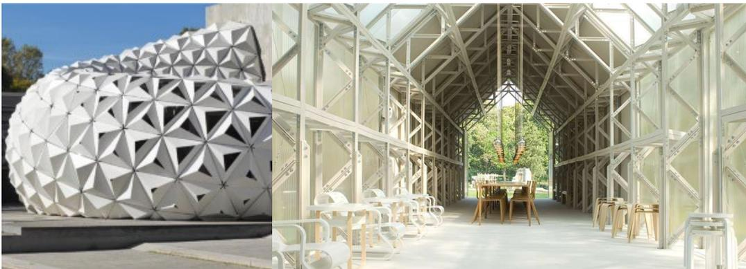
Abbildung 23: (v r n l) Anwendung von Biokunststoffen im Bausektor. Fassaden Mock-Up an der ITKE Universität Stuttgart (System ArboSkin), Artek Pavillon von Shigeru Ban in Mailand von 2007 (gesamtes Gebäude aus UPM ProFi wood plastic) [31].
