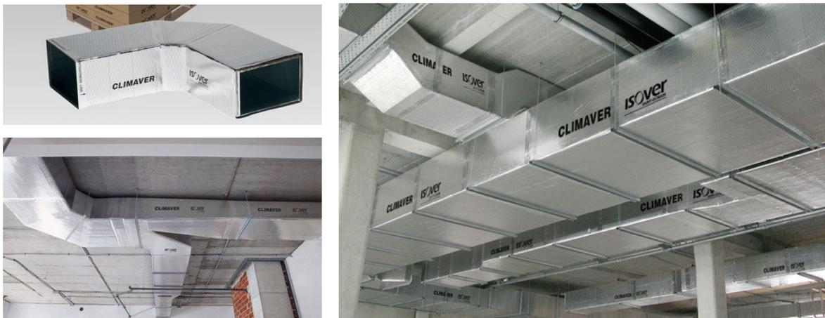
Abbildung 17: Einsatzbeispiele des Systems CLIMAVER® [21]
